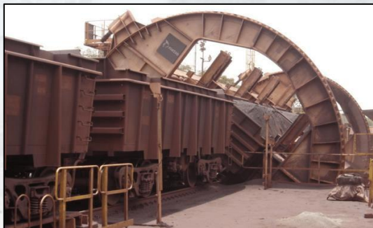
Máquinas de Pátio/Virador de Vagões
