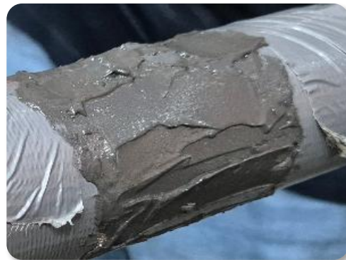
Finalizando o reparo ao redor do furo
