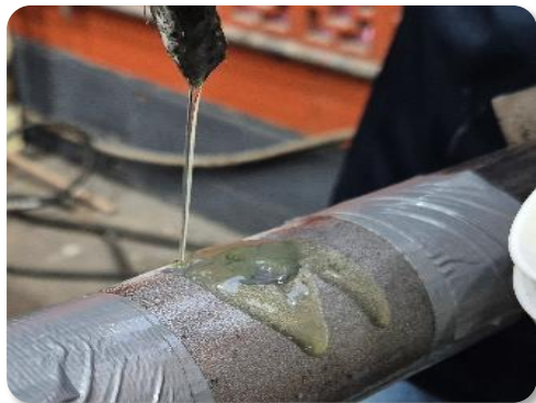
Aplicação de óleo na superfície após vedar o furo
