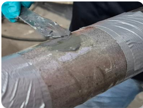
Aplicando o reparo ao redor do furo
