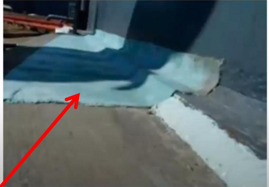
**Vedação da interface chapa/concreto com uma membrana especial para impedir a entrada de contaminantes e a fuga do inibidor de corrosão**
