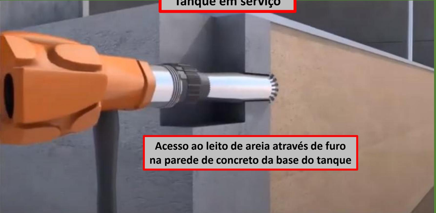
**Acesso ao leito de areia através de furo na parede de concreto da base do tanque**
