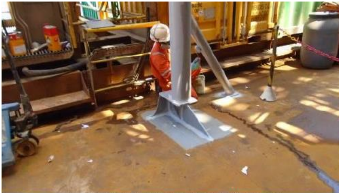
9 – Aplicação da 3ª demão com a tinta Hardtop XP.
