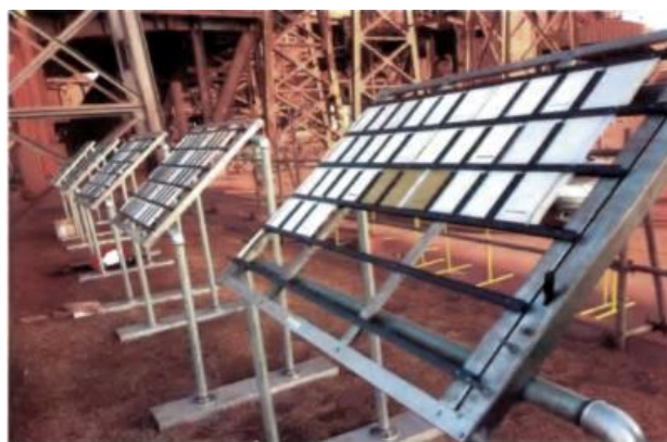
Pier 3 - Porto de Ponta da Madeira (São Luis – MA)
