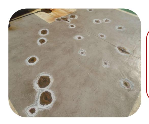
A preparação de superfície em pontos localizados deve ser feita de maneira a ancorar o esquema de pintura de reparo tanto no metal quanto nos seus arredores.
