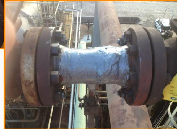
Abraçadeira com Teflon expandido + Adesivo Estrutural + laminado PU
